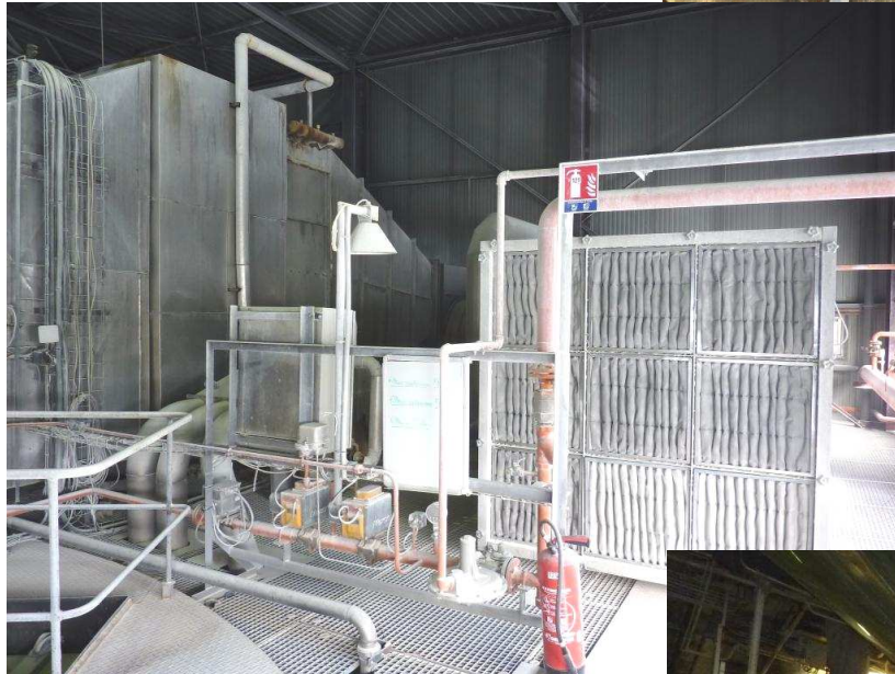
Photo 6 (à gauche) : filtration d'air et panoplie gaz avec détection gaz sur brûleur Maxon
