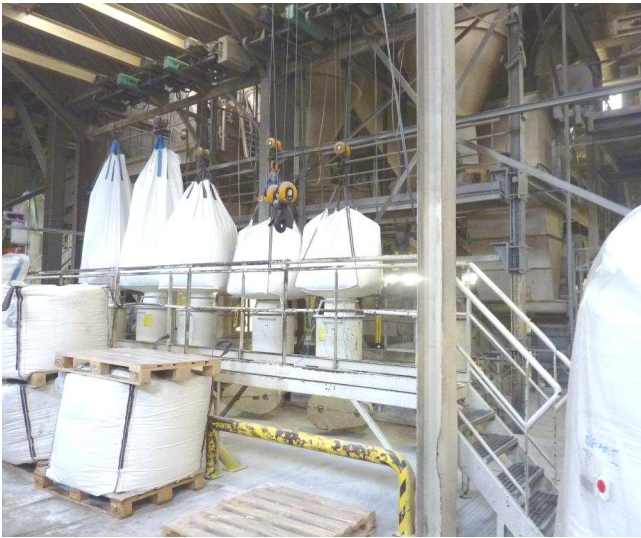
Photo 13 (à droite) : Vue de l'implantation type des cellules, sur bâti métallique sous bâtiment (ossature métallique avec parois bacs et bardages)
