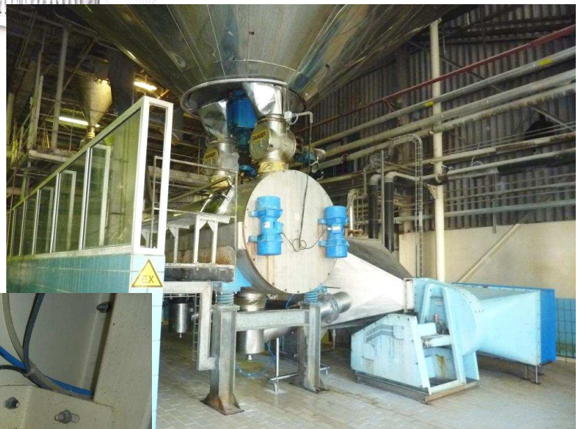
Photo 6 (à gauche) : filtration d'air et panoplie gaz avec détection gaz sur brûleur Maxon
